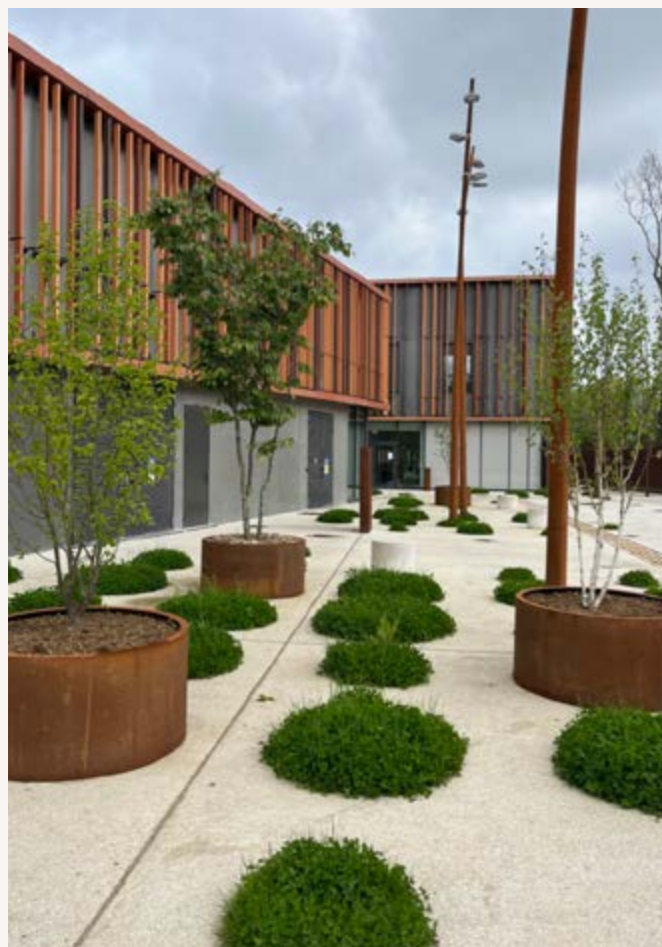
Figure 6 : Site de Maintenance et de Remissage Tram10 | Chatenay Malabry (92) | BEPOS Effinergie 2013 | MO : Syndicat des Transports d'Ile de France | AIA Architectes
