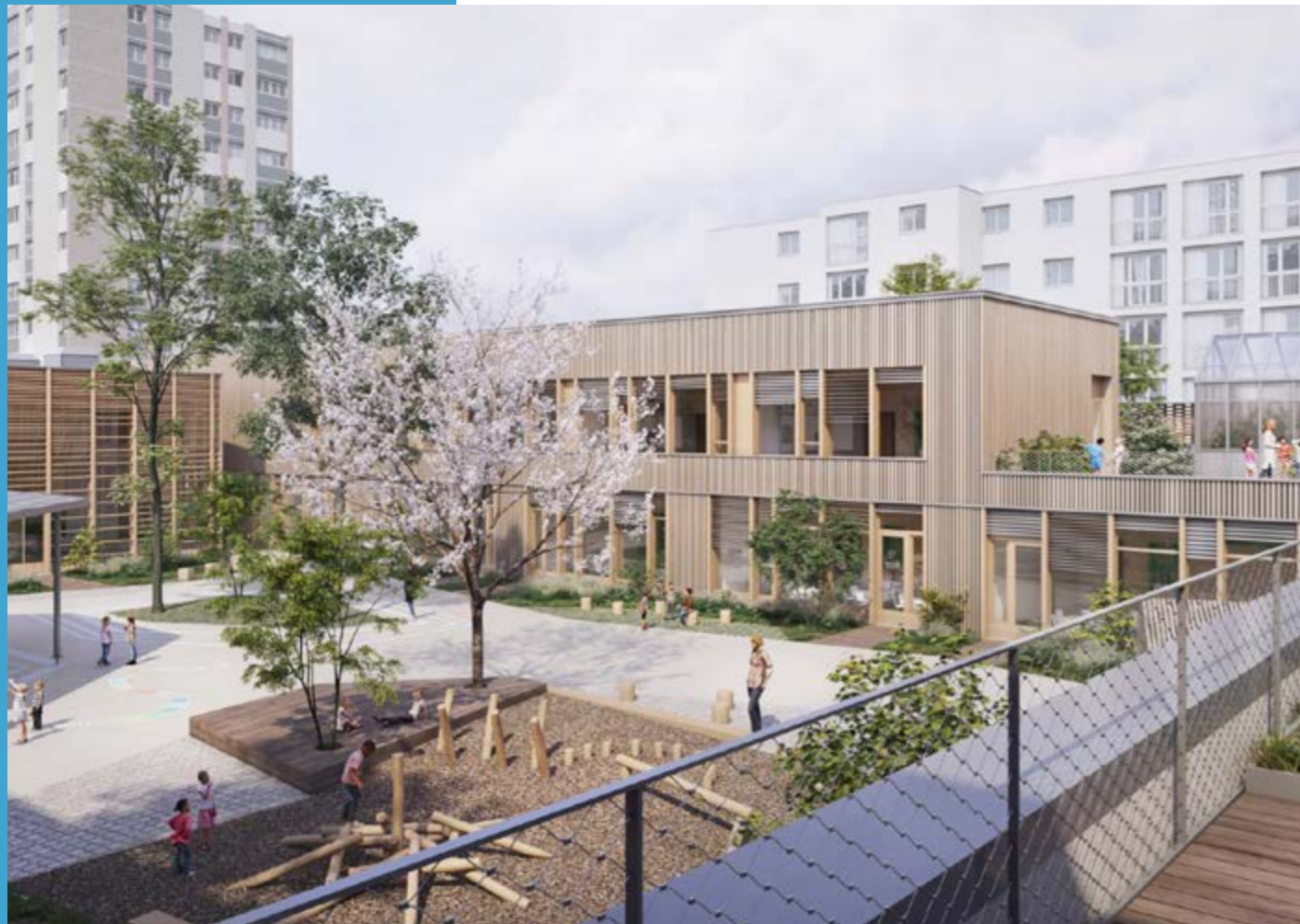
Figure 23 : Groupe scolaire Niki | Bepos Effinergie RE2020 | Petit-Quevilly (76) | Lieux FAUVES | MO : Rouen Normandie Aménagement
