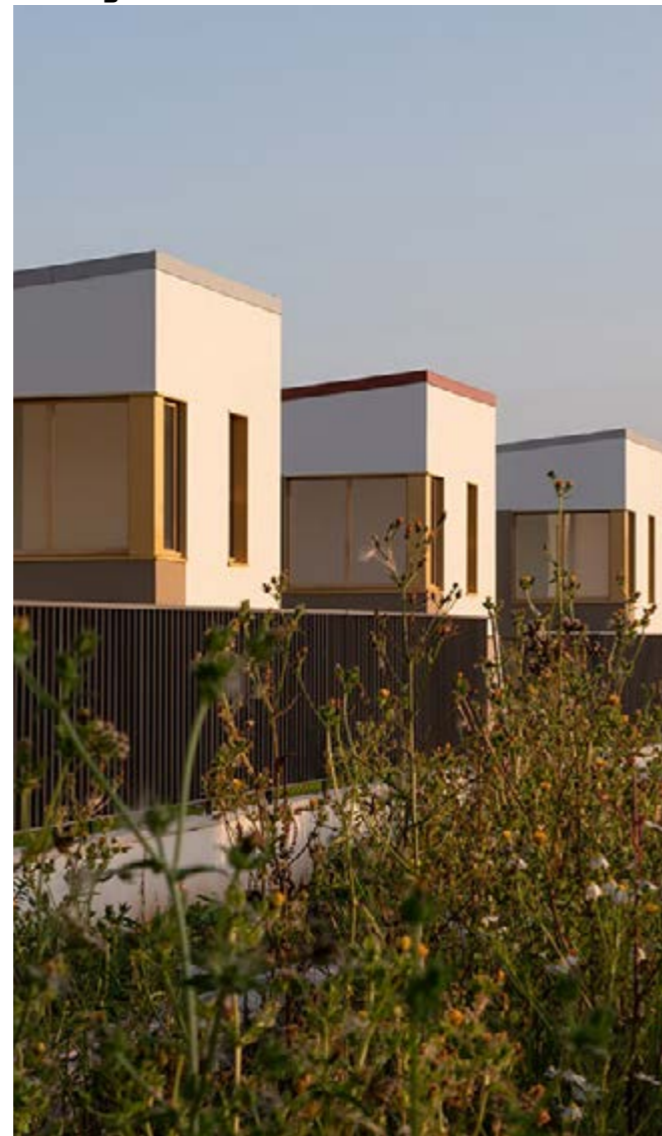
Figure 7 : Zac du Sycamore | Bussy saint Georges (77) | Effinergie+ | MO : Demathieu Bard Immobilier | Architecte : Quadri Flore
